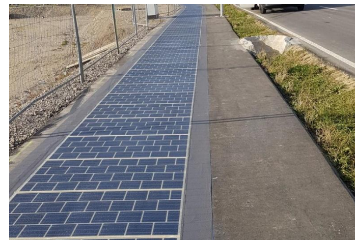
Strade e pista ciclabile che alimentano la rete elettrica
