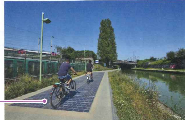
太陽光パネルの外形寸法は1.257m×0.69m×6mm、質量は5.5kg、最大出力は125W。表面には滑り止め加工を施している(出所:コラス、写真:Manuel Lagos Cid-Chump)
