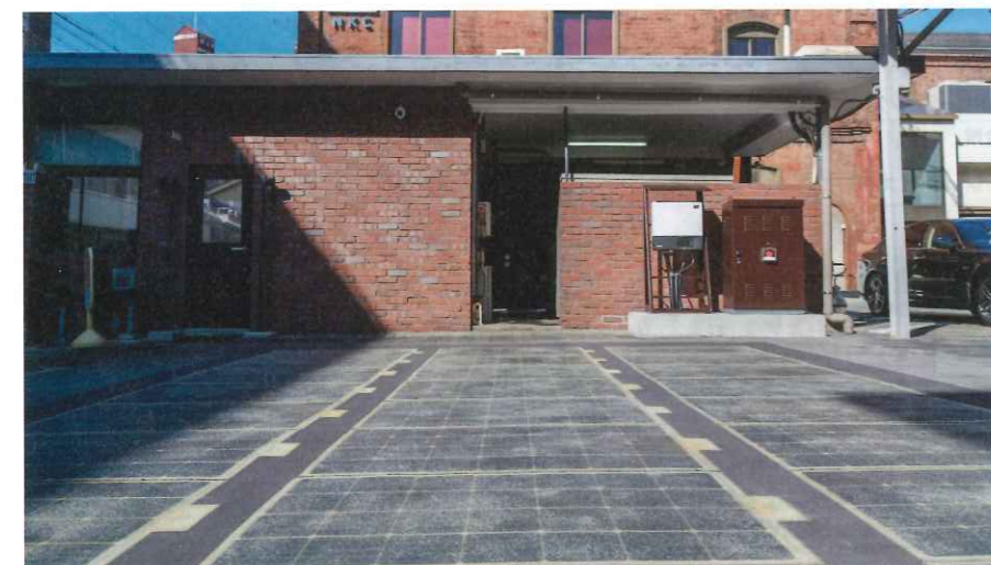
資料4 ■ 太陽光パネルを敷設した路面。中西金属工業(大阪市)の駐車場に2020年10月に設置(写真:David Michaud-Gokan KK)
