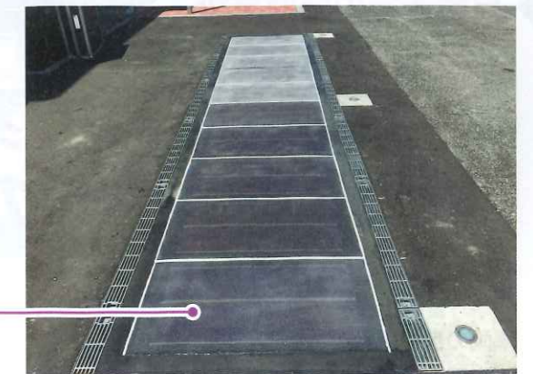
日本道路とF-WAVEが共同で開発する太陽光パネル。外形寸法は1m×0.5m×20mm、質量は26kgほど、最大出力は23W。滑り抵抗値は60BPN以上(出所:日本道路)
