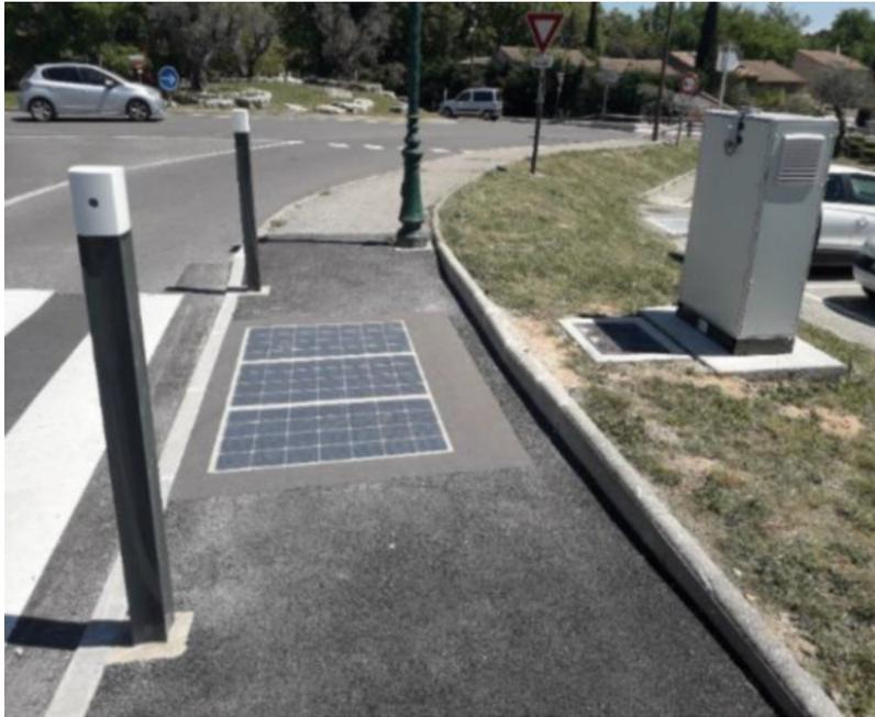
Die Wattway-Elektronik (Steuerung, Batterien, usw.) wird in einem Schaltschrank installiert. Der Schrank wird auf einer Betonplatte installiert und befestigt. Die zu versorgenden Geräte müssen sich in einem Umkreis von 10 Metern zum Schrank befinden. An der Vorderseite muss genügend Freiraum vorhanden sein, damit die Tür geöffnet werden kann (Türblatt ca. 70 cm).
