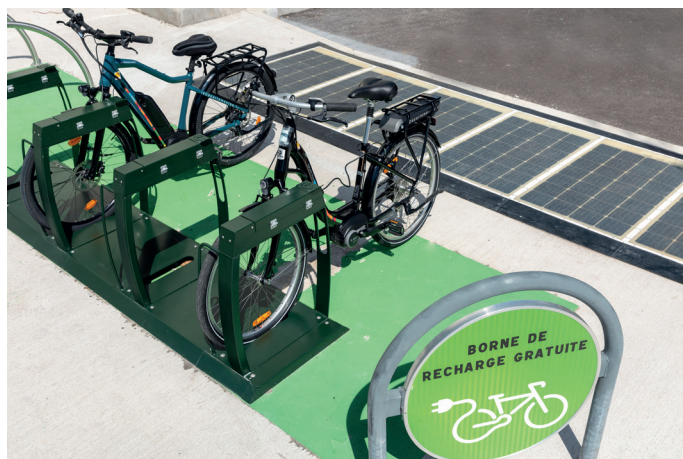
Un Wattway Pack de 6 dalles permet l'autonomie de 4 bornes de recharges vélo
