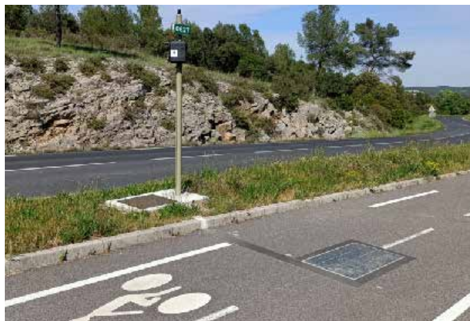
1 dalle Wattway permet de rendre autonome le compteur vélo
