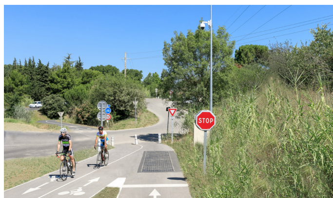
Montpellier, France - 12 dalles alimentent une caméra de supervision
